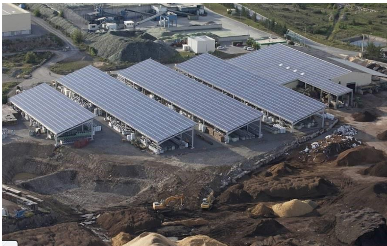
Figure 11 : Projet similaire réalisé sur le site de Lavilledieu (07)
