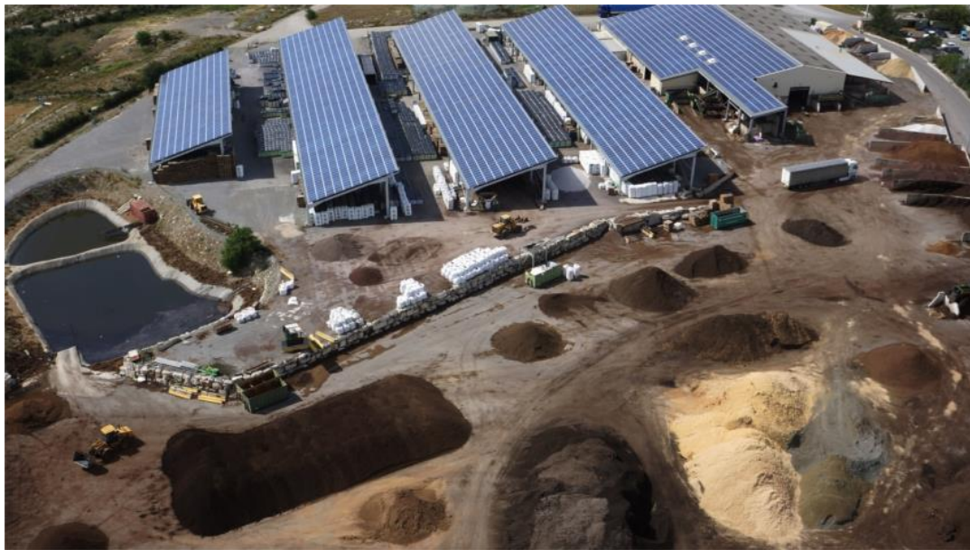
Figure 10 : Projet similaire réalisé sur le site de Lavilledieu (07)
